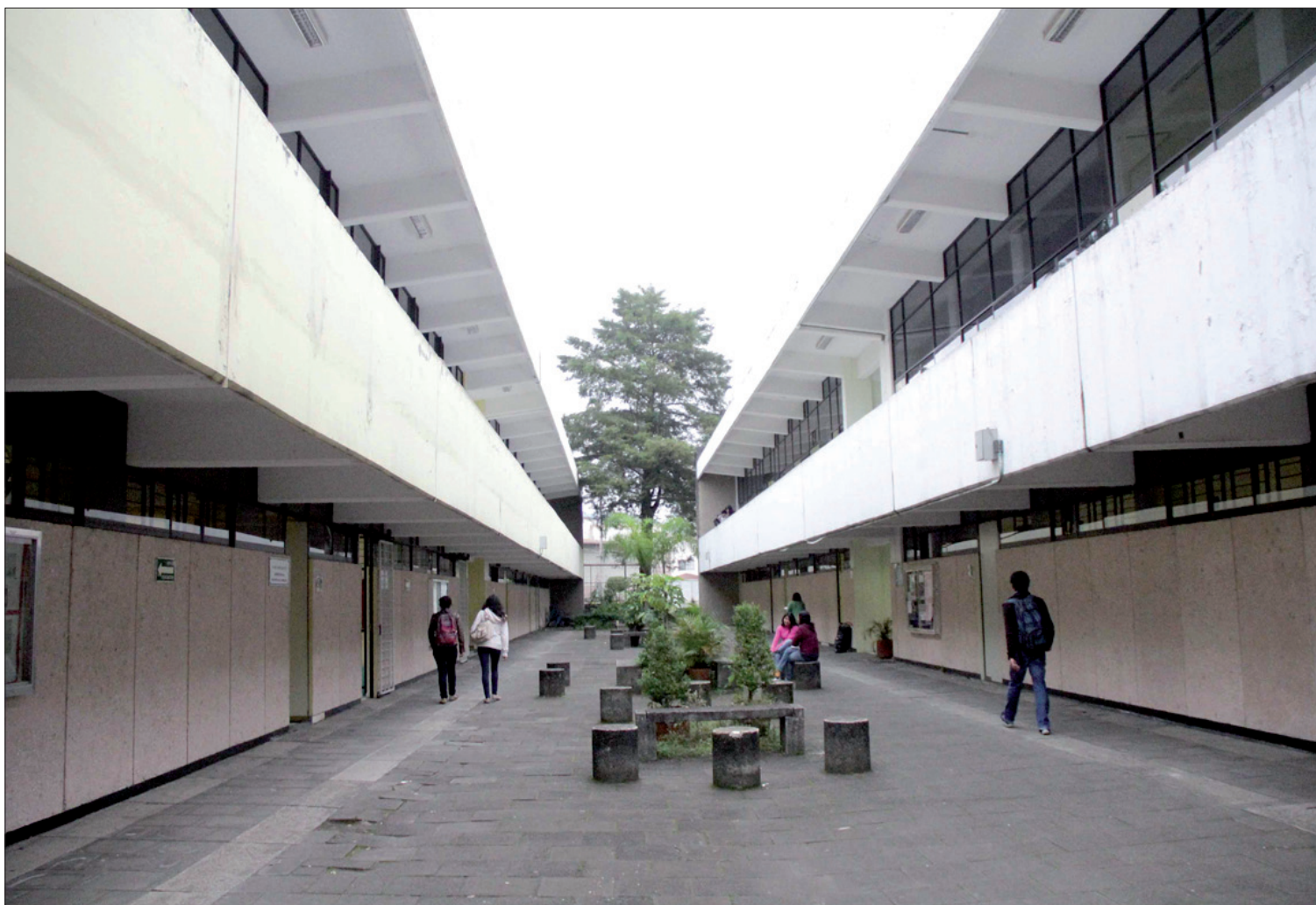
Los nuevos equipos benefician económicamente a la Facultad
